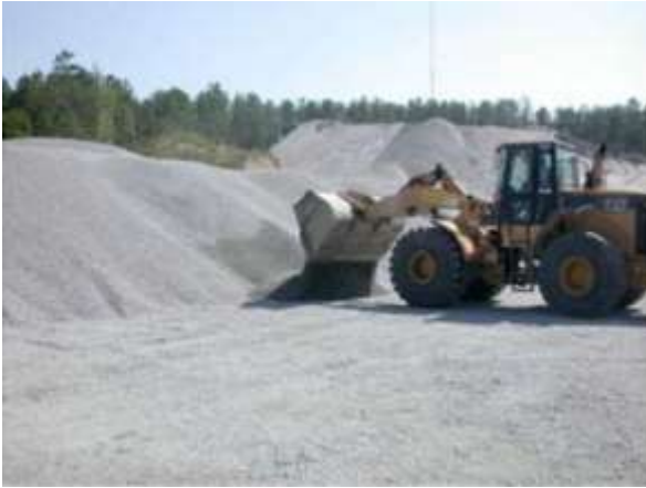
مرحله ۲- لودر مصالح را برای تشکیل دپو به آرامی از زمین وارد دپو می‌شود. جام بیرون می‌ریزد.
