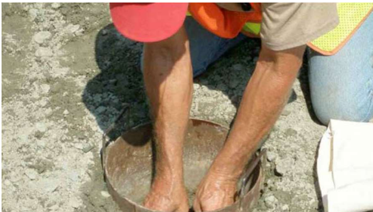
شکل ۵- نحوه استفاده صحیح از قالب فلزی برای نمونه برداری از مخلوط سنگدانه درشت و ریز از لایه‌های زیرسازی جاده
